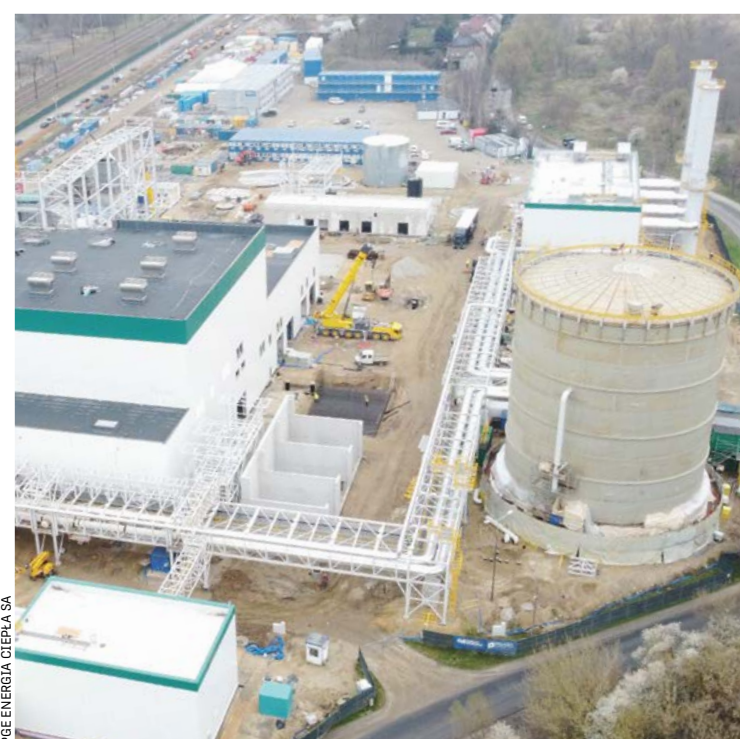
Akumulator ciepła w budowie – będzie miał 34 m wysokości
